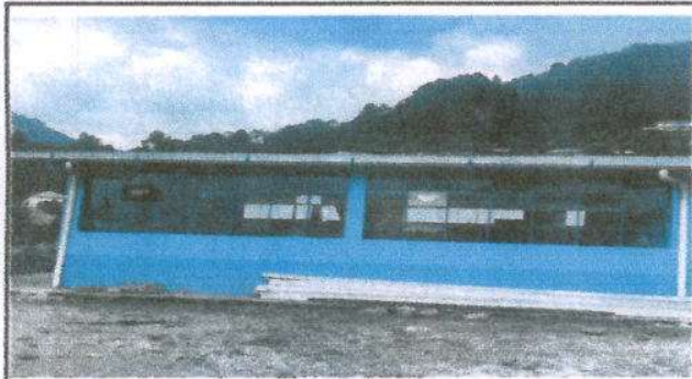
Foto 3: Sustitución de canal de metal
